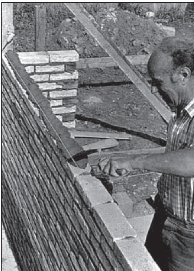
Extender primero una capa de mortero.
