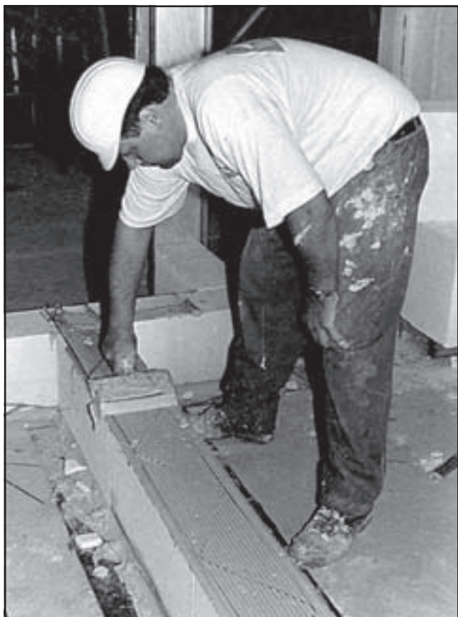
3. Aplicar una segunda capa de mortero cola por encima.
