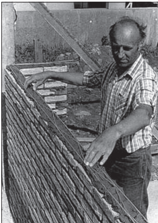
Introducir la armadura Murfor® RND 1cm en el mortero.
