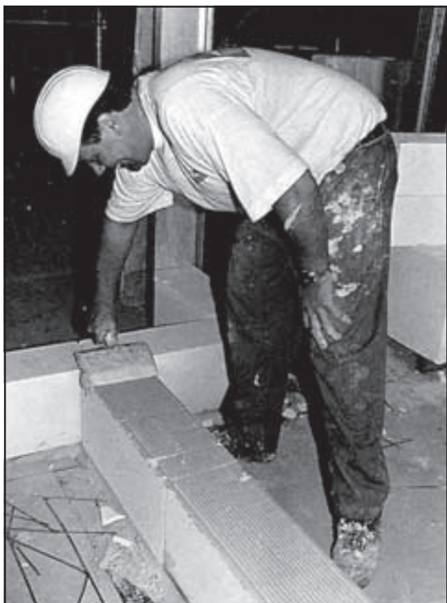
1. Aplicar una capa de mortero cola.
