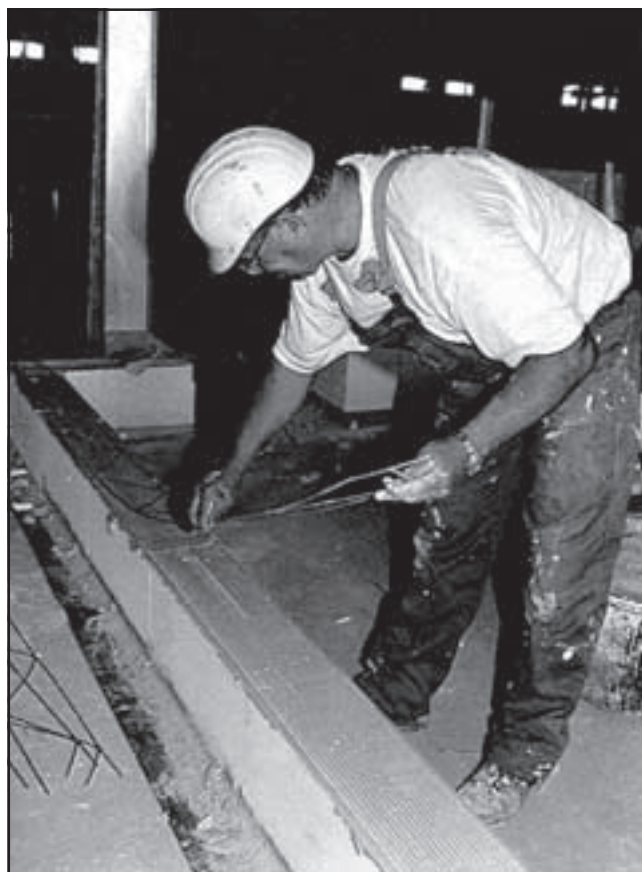
2. Introducir en ella la armadura Murfor® EFS.
